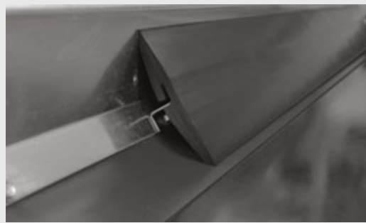
Joint d'étanchéité lisse entre panneau latéral et bande
